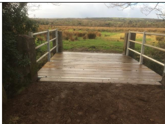
Tar éis na n-oibreacha
